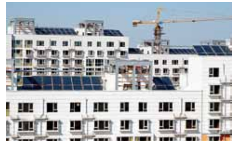
Edificio residencial con sistema de calefacción solar centralizado para agua en Baoding
